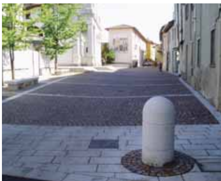
Lavori completati sul piazzale
