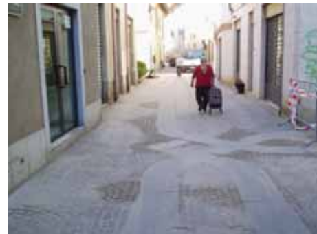
Lavori di manutenzione via S. Stefano completati
