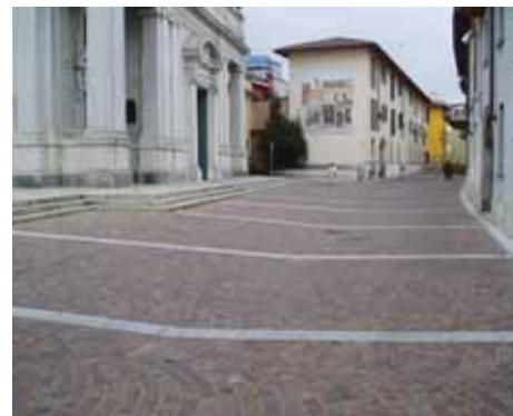
Lavori completati sul piazzale
