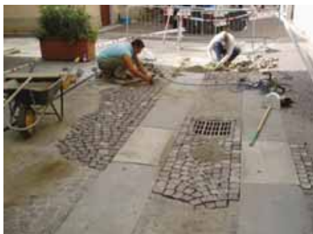
Lavori in corso di manutenzione della pavimentazione di via S. Stefano
